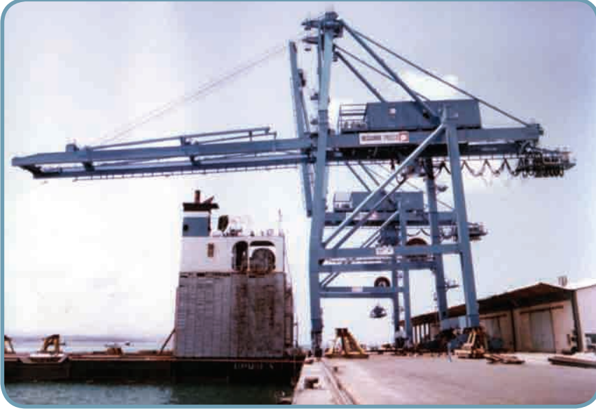
مشروع تطوير ميناء جيبوتي
