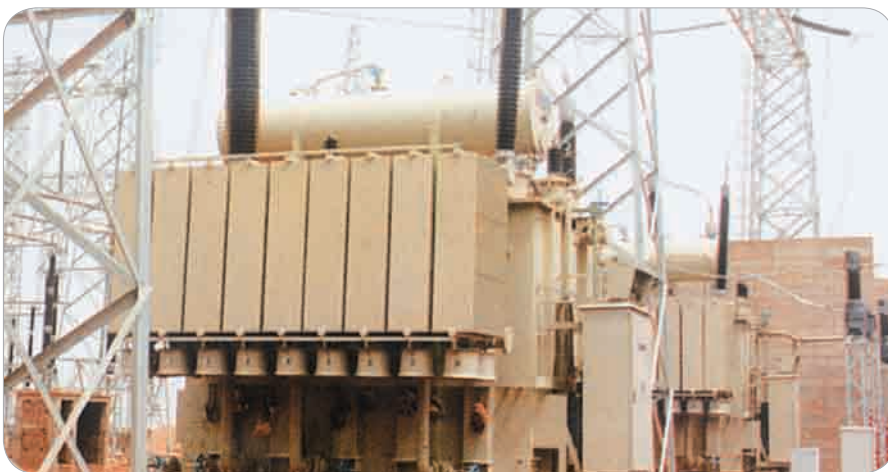
• جانب من الأعمال والانشاءات الخاصه بتوليد الكهرباء بالسد
