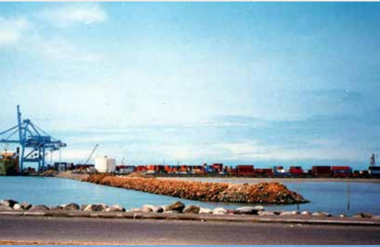
مشروع تطوير ميناء جيبوتي
